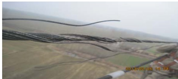
图 2 500kV 伊上线#237~#238OPGW 断股现场照片
